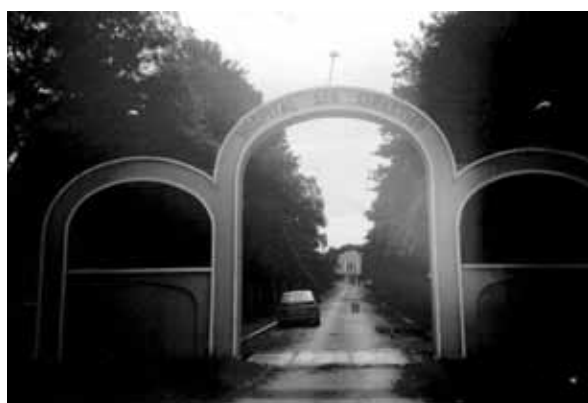
- Portal reconstruído, tendo ao fundo o edifício hospital central
